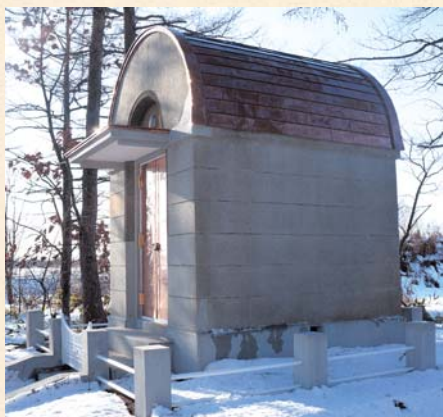
修理工事後の旧柏野尋常小学校奉安殿 (平成27年)
