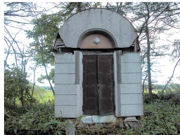
修理工事前の奉安殿（平成24年）
