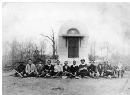
旧柏野尋常小学校奉安殿竣工時（昭和12年撮影）
