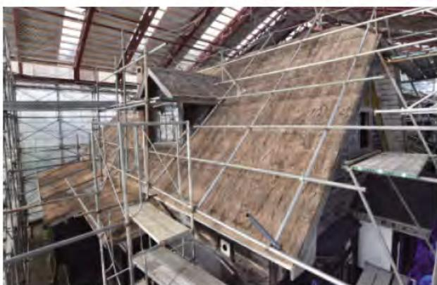
写 3-5-14 「南棟」 下葺とした桁葺
