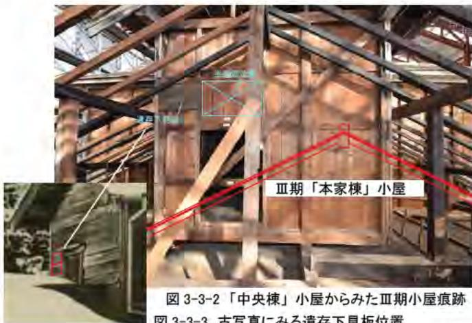
高が同じと考えれば梁間は現状より1間狭くなり4間半であったことが想定される（図3-3-4）。この梁間4間半は昭和6年の規則改正付図「駅逦所建築標準図」に描かれた梁間寸法と合致する。なお、この想定図から考えると桁高が低くなりすぎるため床が現状より低かった可能性がある。現状では「中央棟」から「南棟」にかけて盛土されているが、地山は南へ傾斜して下がっている。このためIII期までは「北棟」周囲より地面が低く、昭和16年の増改築時（IV期）に盛土を行った可能性が高い。
