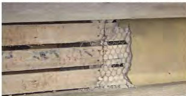
写 3-5-21 「中央棟」セメント壁解体時状況
