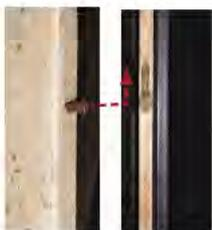
写 3-5-31 木ネジを用いた縁打ち寄蟻の要領で堅縁の逃穴に木ネジの頭を入れ寄せて留める
