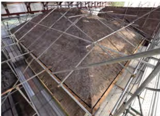
写 3-5-12 「北棟」 鉄板下に遺存していた桁葺
