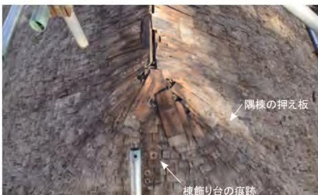
写 3-5-13 「北棟」 鉄板下に遺存していた桁葺
