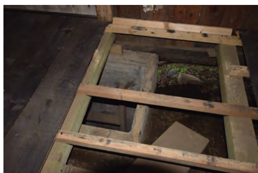
床下に遺存していたムロの開口部
