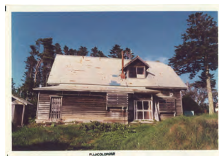
鋼管を使用した時期の煙突 (昭和59年撮影)
