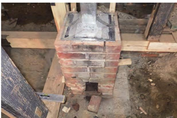
煙突補強鋼管とプレート施工状況
