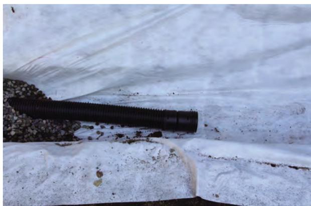
雨落溝有孔管、砂利敷設状況
