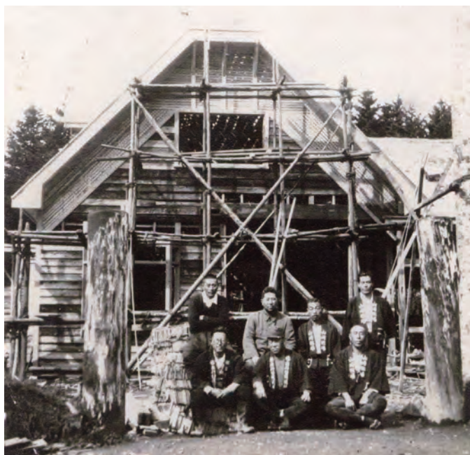
史 14 「南棟」 改築工事中（昭和 16 年）
