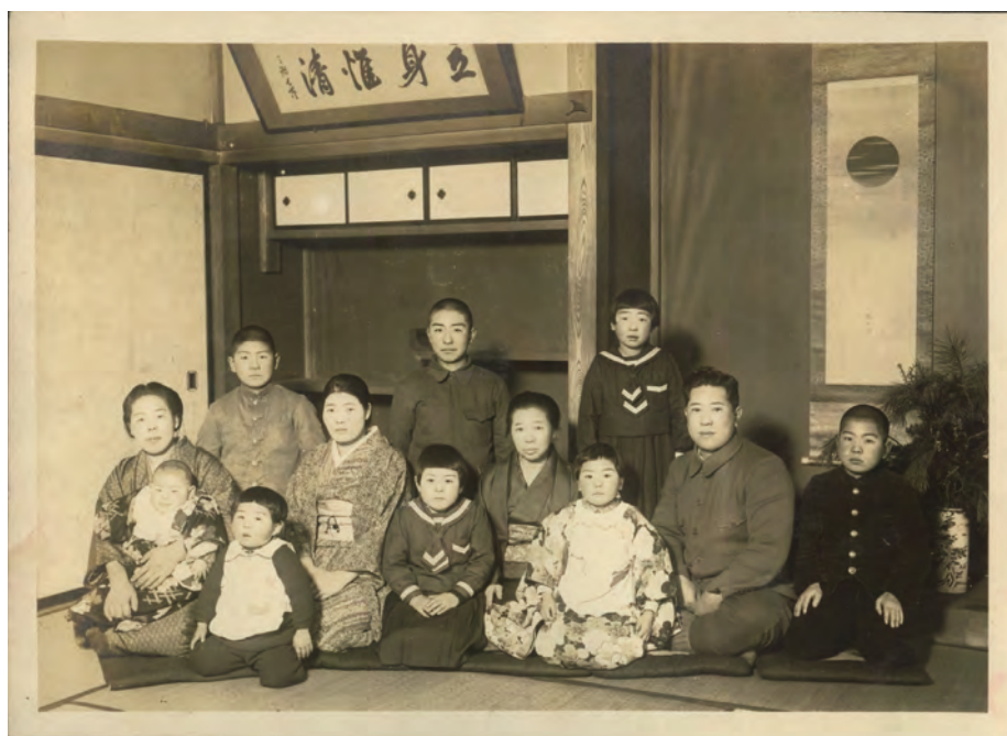
史 11 「北棟」 客室 5（昭和 15 年）
