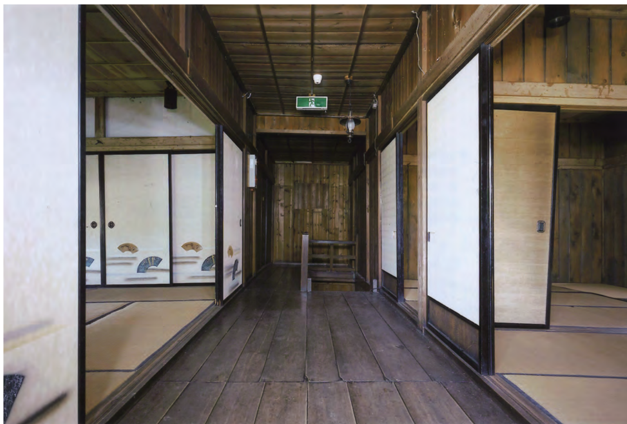
【修理前】二階廊下 北よりみる
