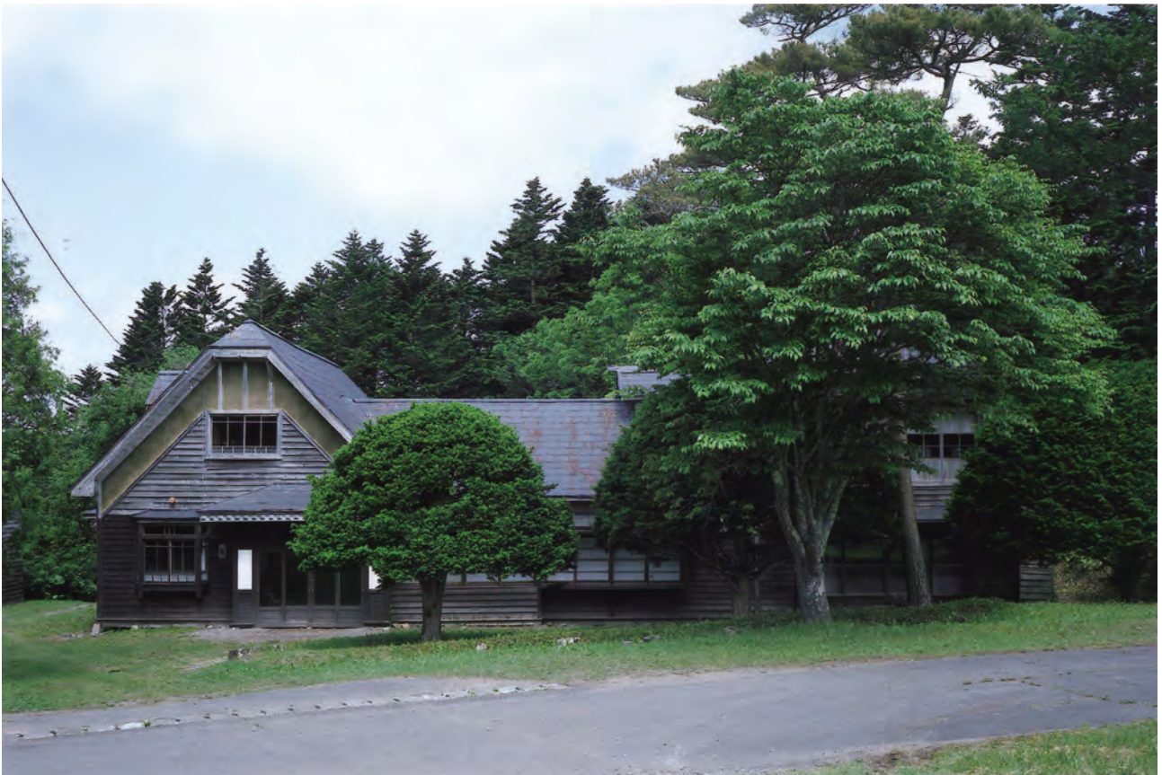
【修理前】 外観正面（東面）
