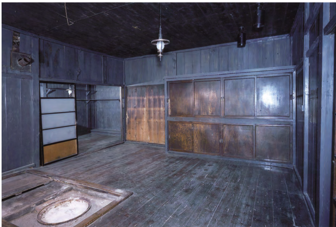
【修理前】居間北東より台所を見通す
