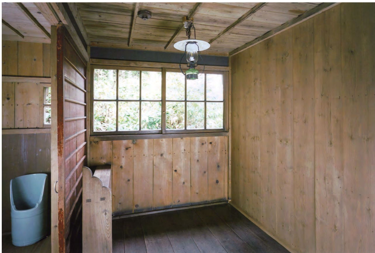
【竣工】洗面所 南西よりみる
