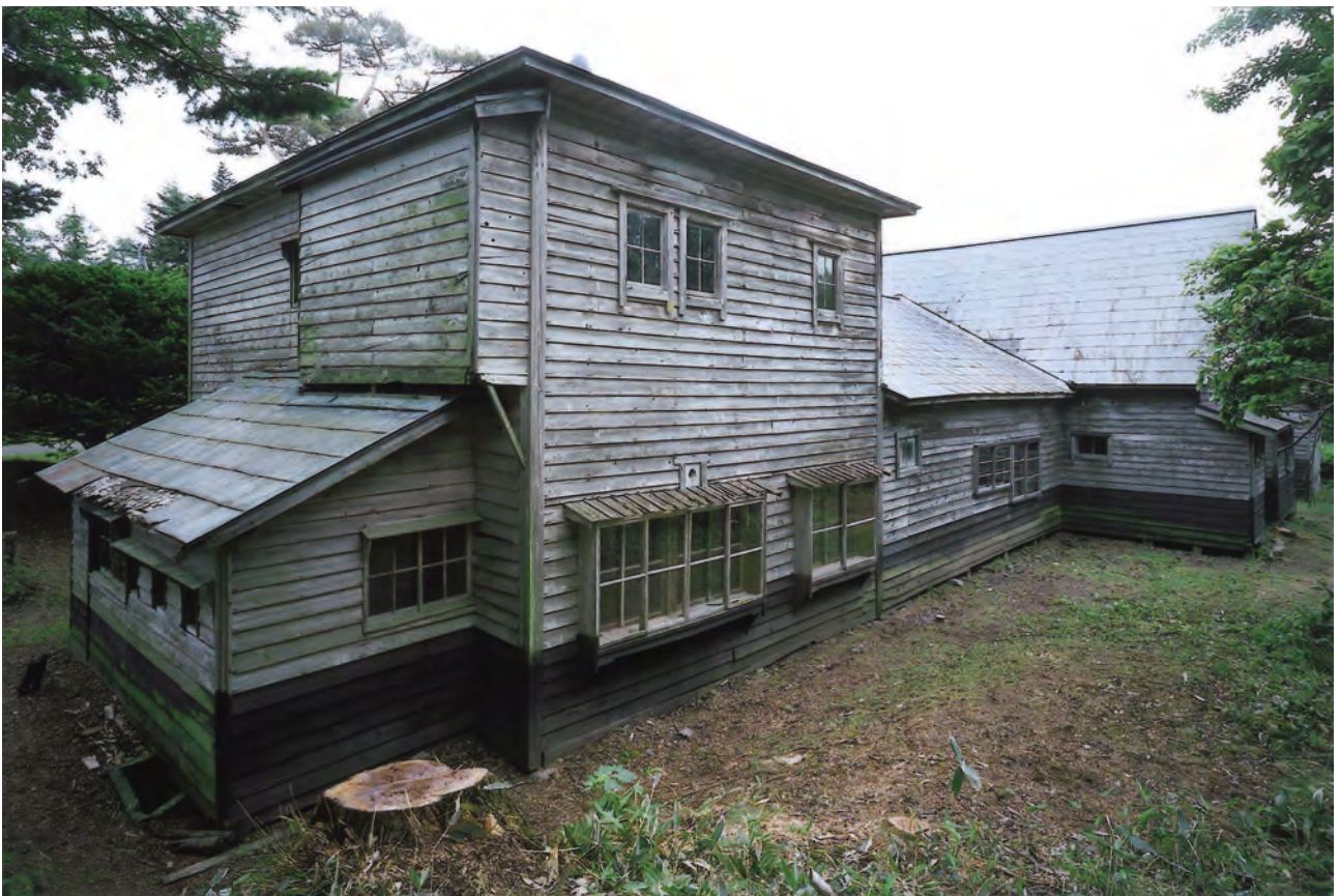
【修理前】外観 北西よりみる
