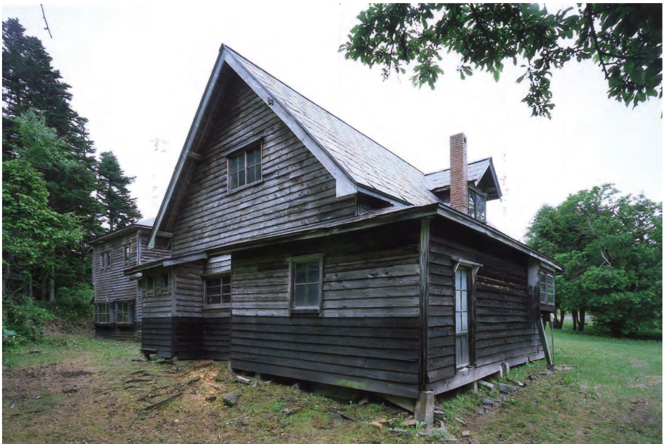
【修理前】外観 南西よりみる
