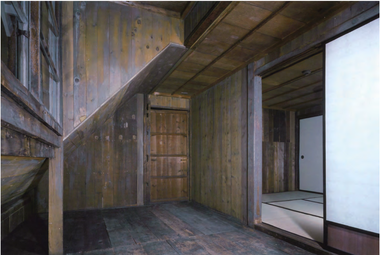
【竣工】小屋裏廊下南東より和室 1 を見通す
