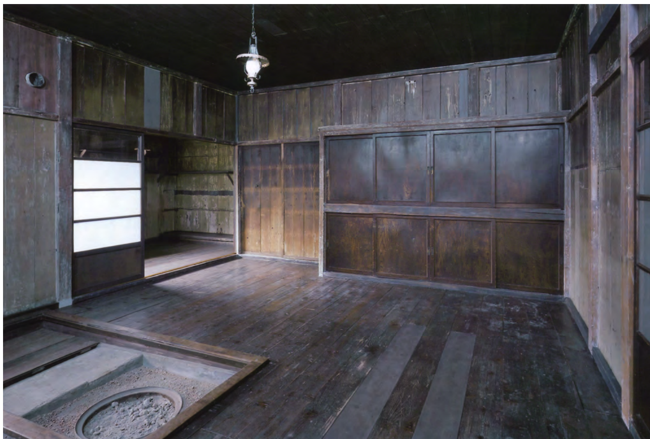
【竣工】居間北東より台所を見通す
