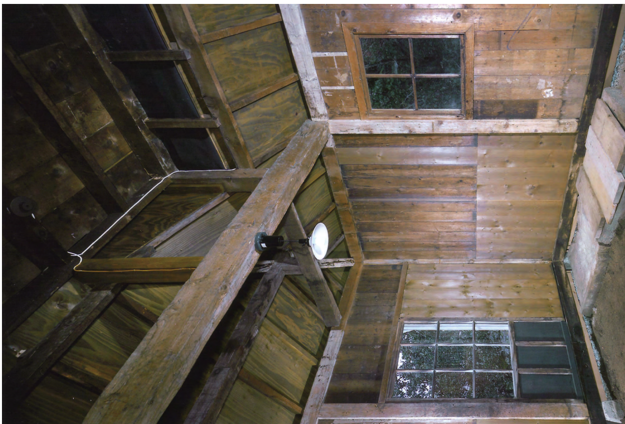
【竣工】物置 北東よりみる
