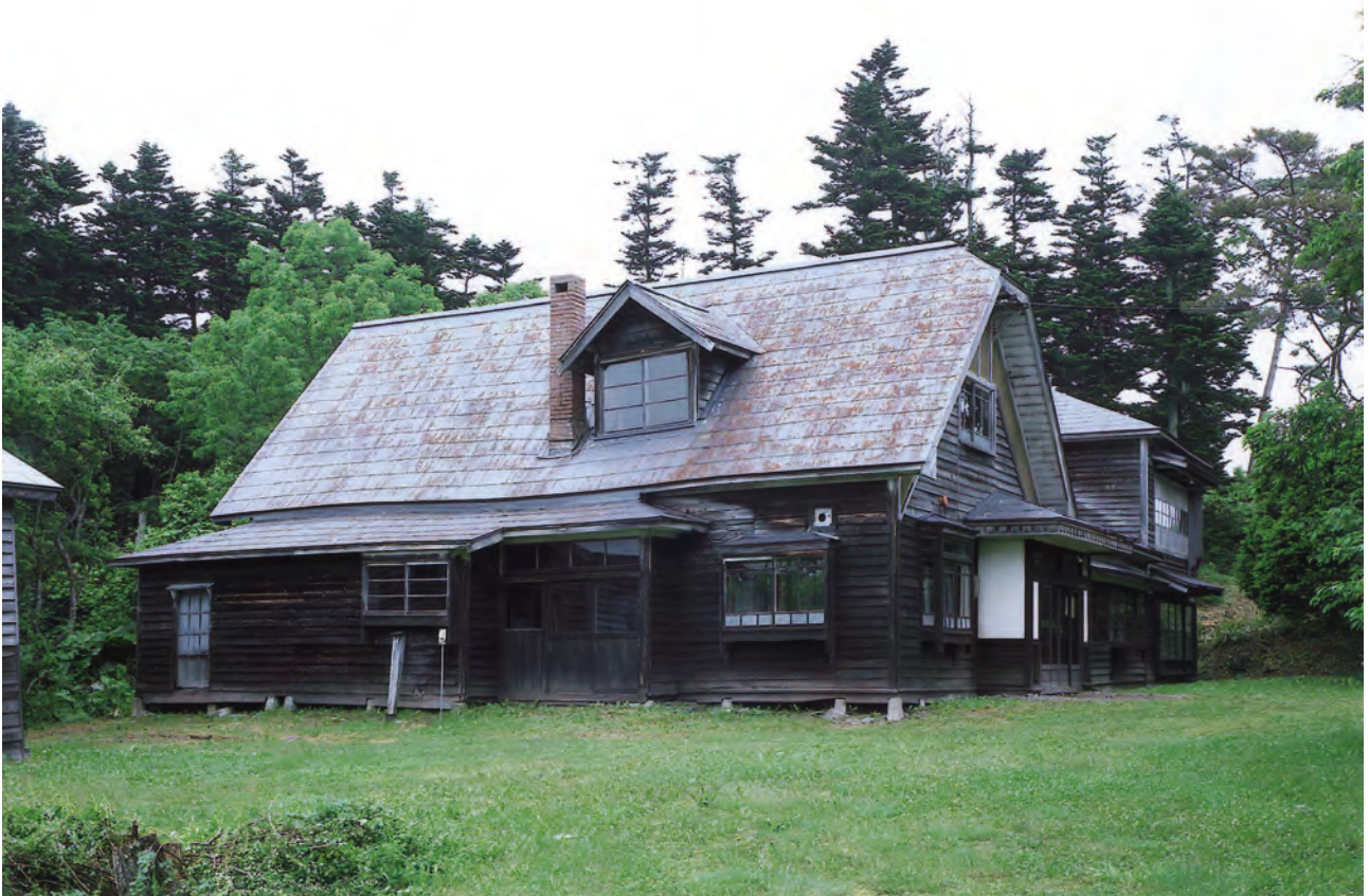
【修理前】外観 南東よりみる
