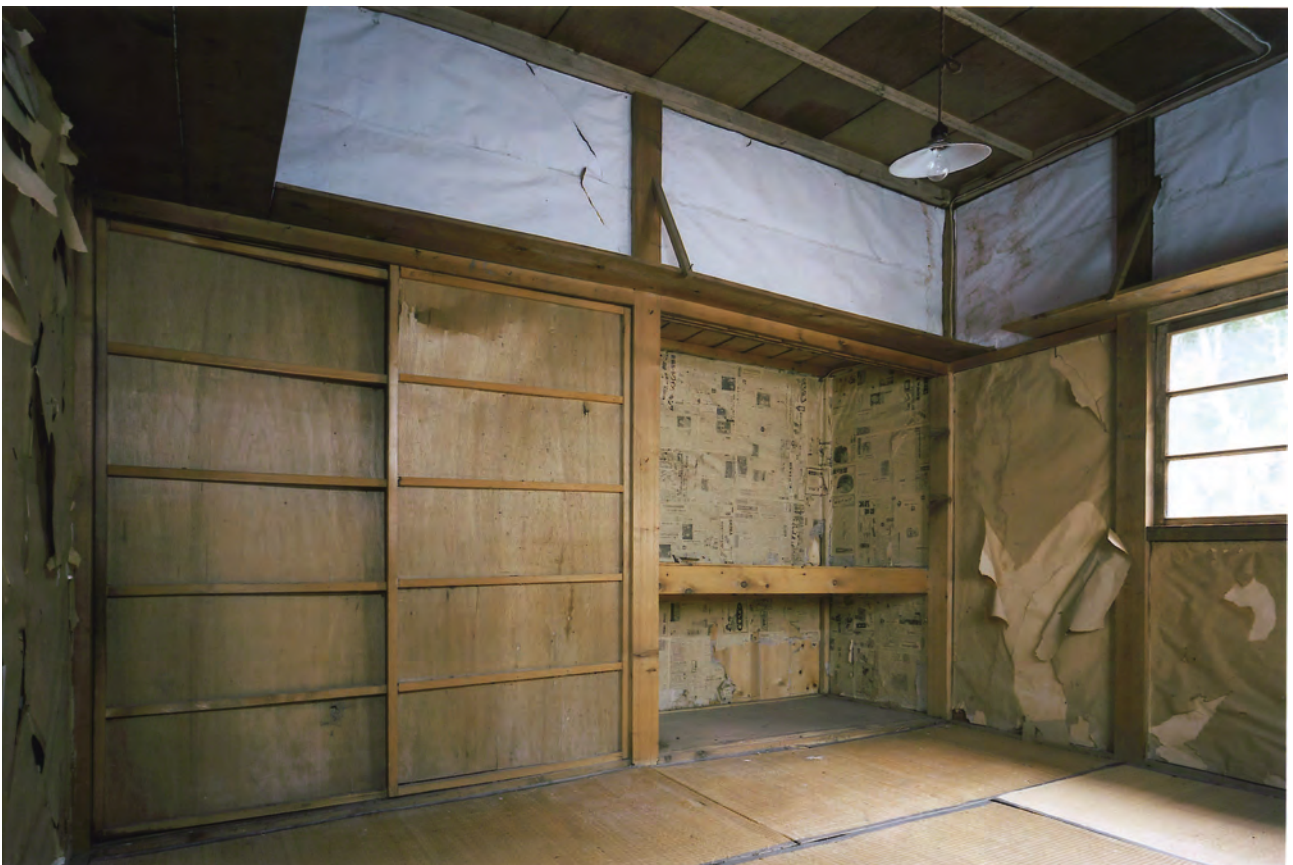
【修理前】使用人室 北東よりみる
