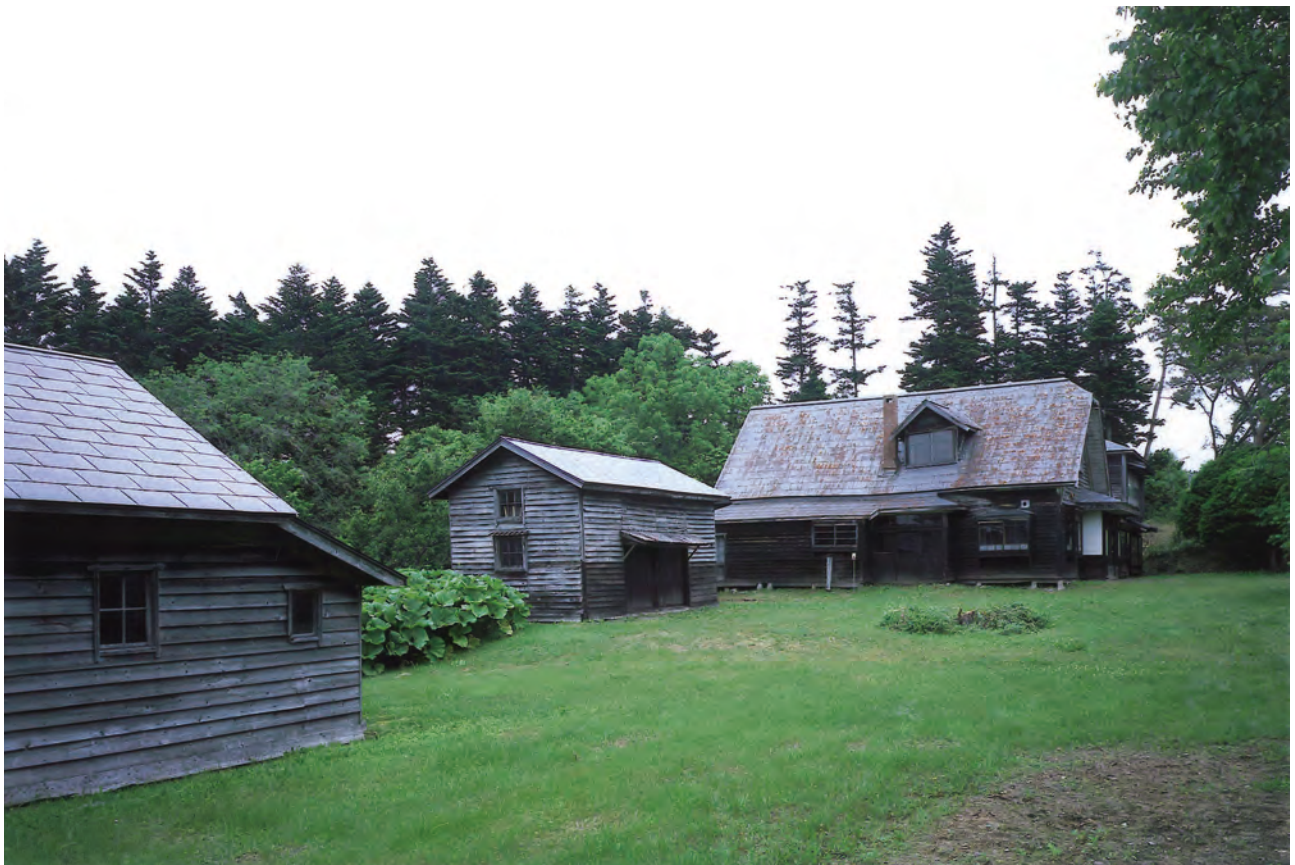
【修理前】外観 南東よりみる
