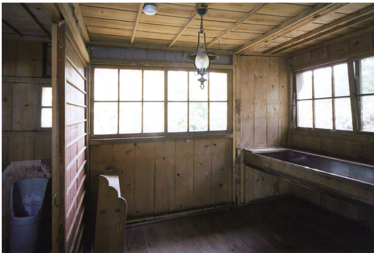
【修理前】洗面所 南西よりみる
