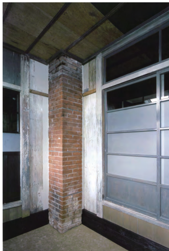
【竣工】裏玄関煙突
