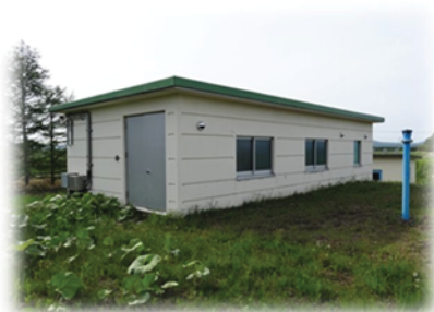
泉川浄水場(深井戸整備中)
