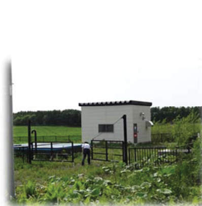
西泉取水井戸（整備中）
