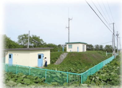
西春別浄水場
