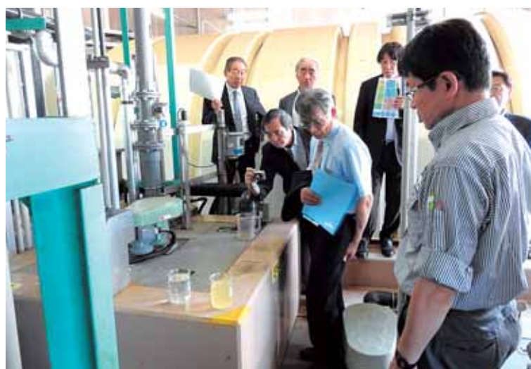
水環境の保全に配慮した浸出水処理施設
