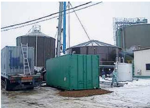
バイオガス精製・改質・充填装置（外観）
