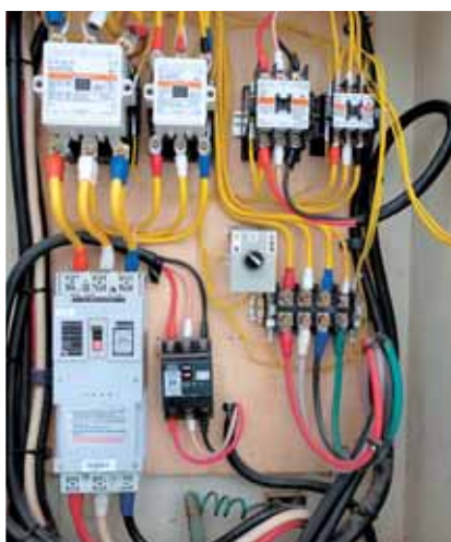
町内酪農家の非常用電源の最新の配備状況は688戸中287戸であり早急な整備が求められている
