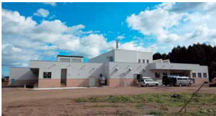
建設中の給食センター
