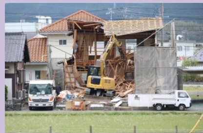
解体工事のイメージ
