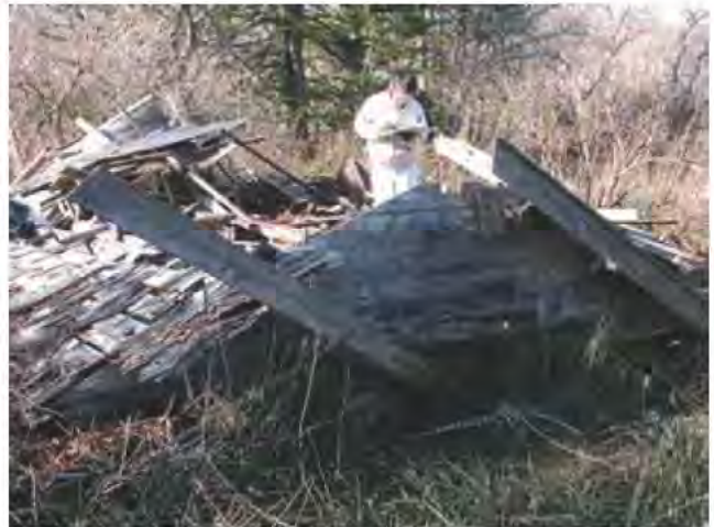
写真 1 材木小屋調査時
