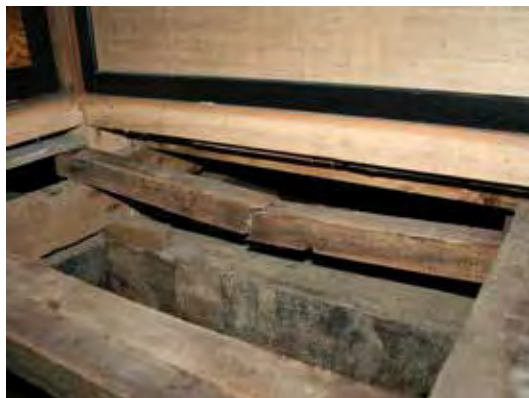
写真 2 茶の間 折損している根太
