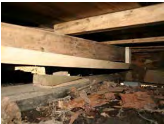
写真 7 客室 3 床下状況
