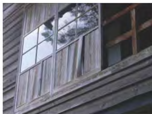
写真4 腰板の腐朽
