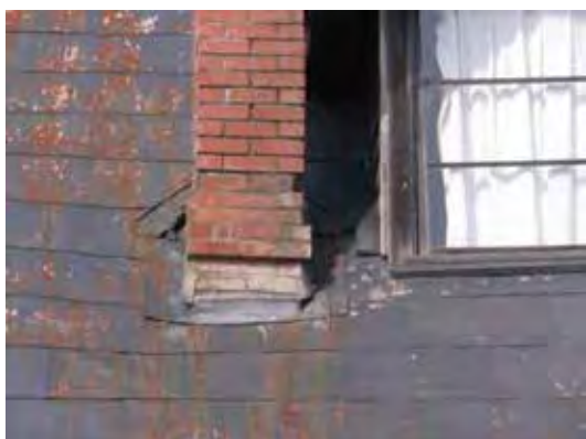
写真 37 煉瓦の欠損
