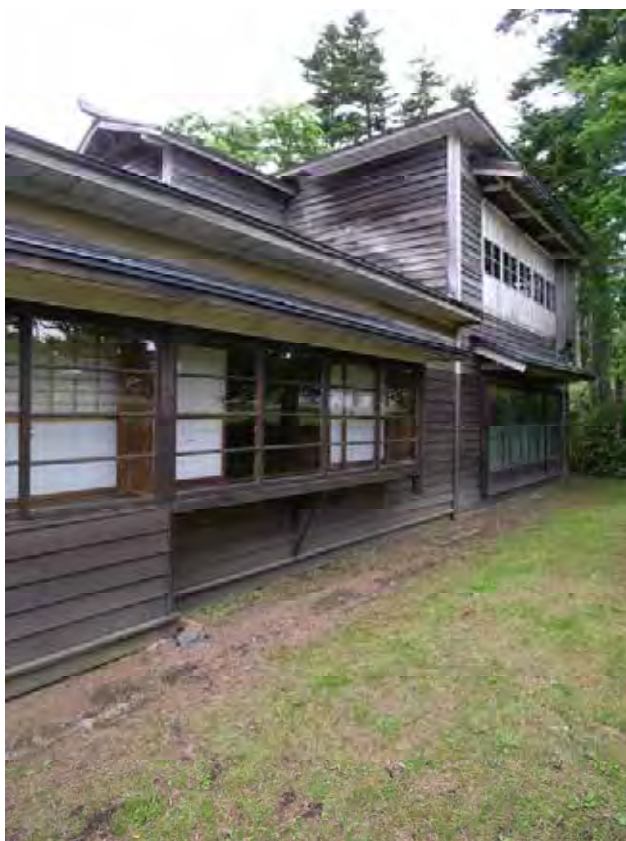
左：中央棟、右：北棟 東側
