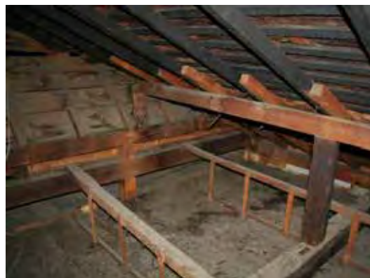
写真2 中央棟小屋裏 南棟境
