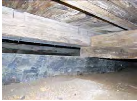
写真 10 客室 5 床下の状況
