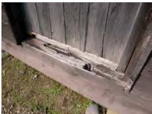
写真 35 敷居の腐朽
