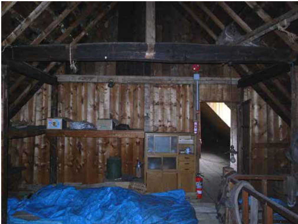
南棟2階 小屋裏物置
