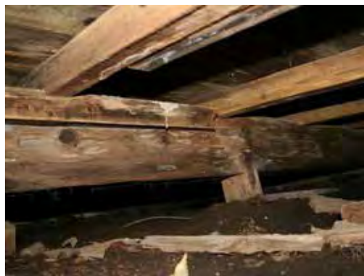
写真 8 客室 3 床下状況
