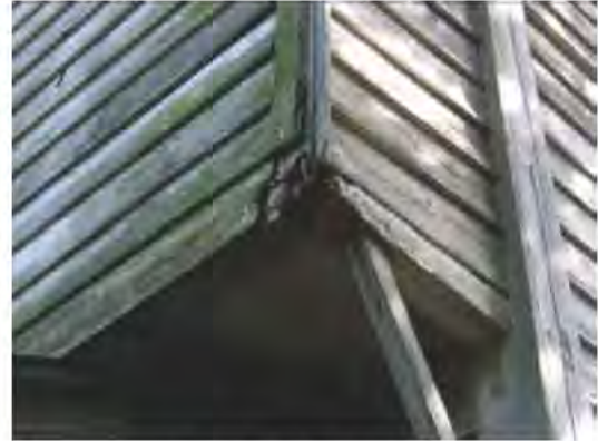
写真 48 下框の腐朽
