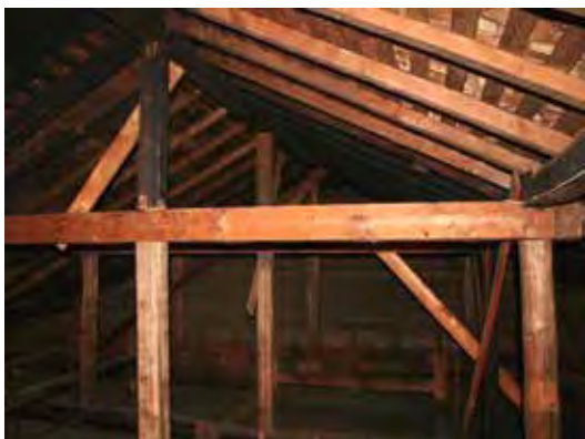
写真1 中央棟小屋裏 南棟方向
