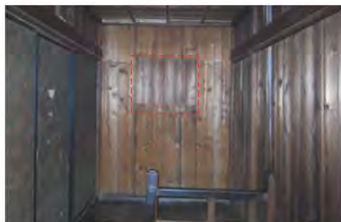
中央棟 2 階廊下の壁に残る窓跡
