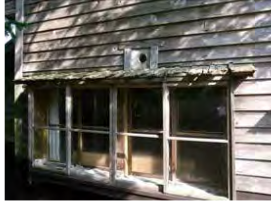
写真 40 庇の腐朽
