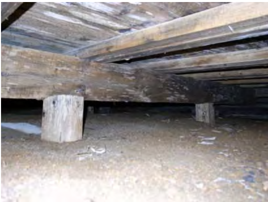
写真 11 客室 5 床下の状況
