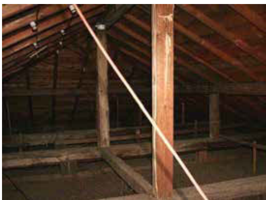
写真5 北棟小屋裏 西方向
