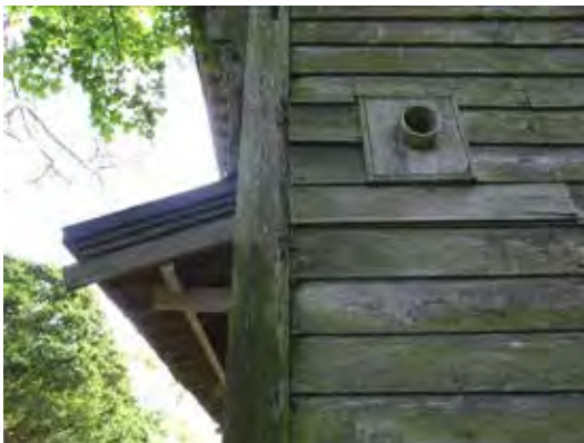
写真 43 柱の腐朽
