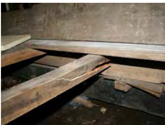
写真 3 茶の間 折損している根太
