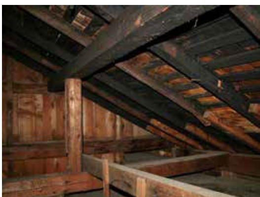
写真3 中央棟小屋裏 北棟方向
