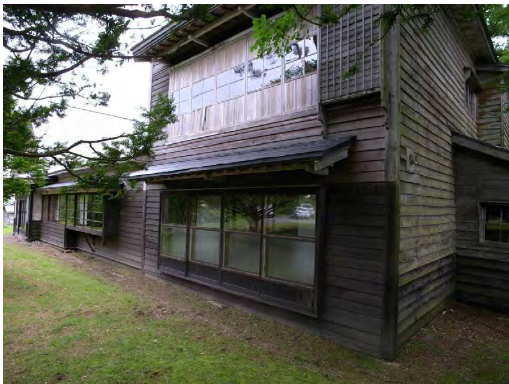
左：中央棟、右：北棟 東側
