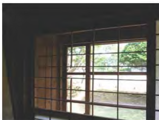
写真1 組子の欠損
