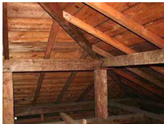
写真6 北棟小屋裏 隅部
