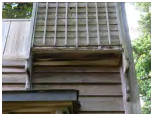
写真 32 水切りの欠損
