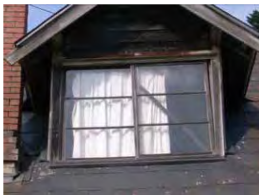
写真 38 窓枠の傾斜
