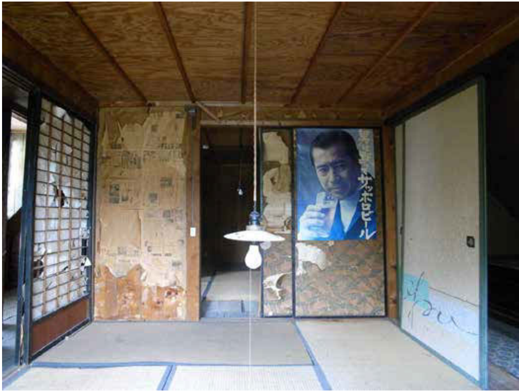
南棟2階 手前：和室2、奥：和室1
