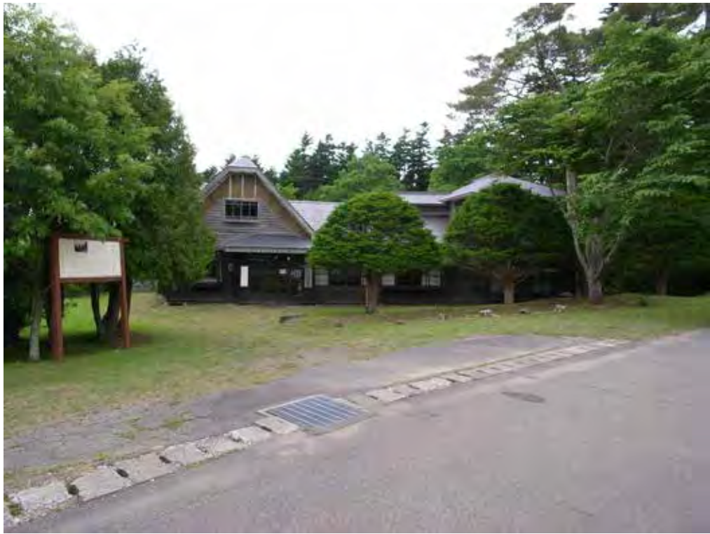
全景、東側前面道路より
