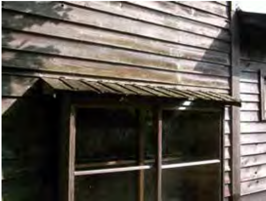
写真 41 庇の腐朽
