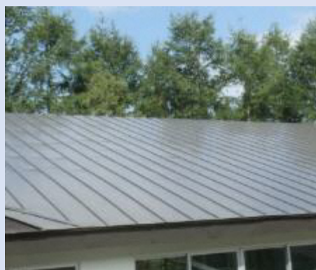
屋根(改修済み)
