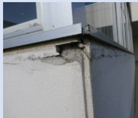
サッシ下部充填モルタル隔離
