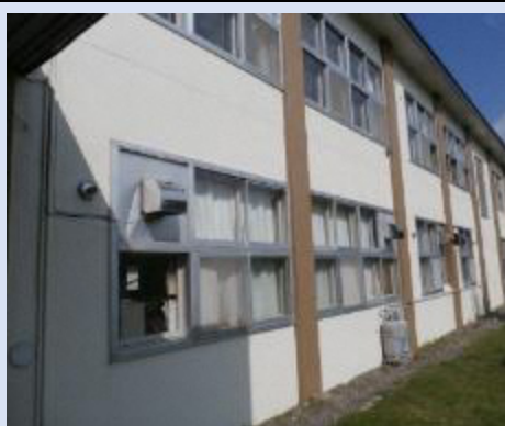
外壁(改修済み)
