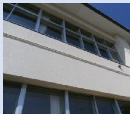
近年改修された外壁
