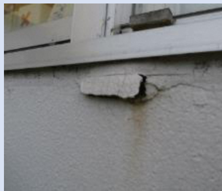
サッシ下部充填モルタル隔離
