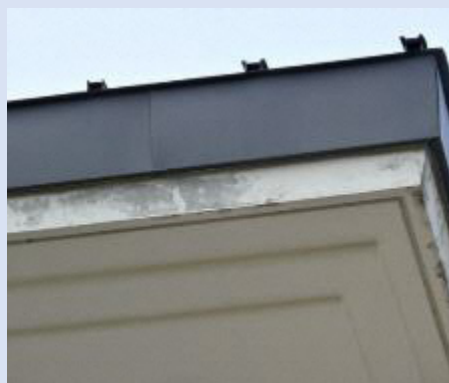
屋根(軒)周辺の状況
