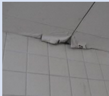
内装(トイレ天井)
