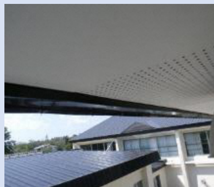
近年改修された屋根・軒天
