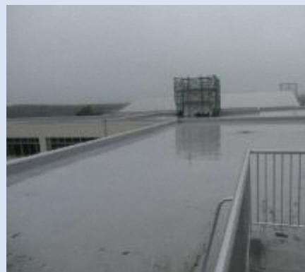
屋上防水(改修済み)
