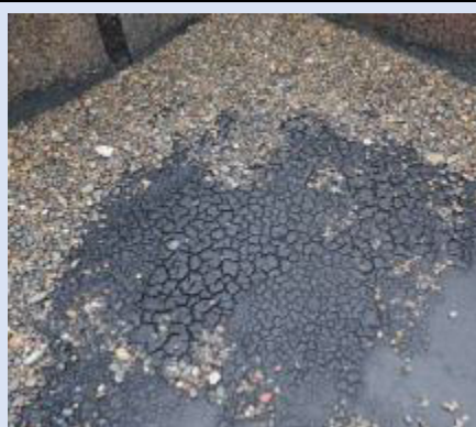
屋上防水(アスファルト防水)
