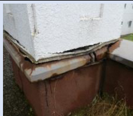
コンクリート柱下部(2F屋上)
