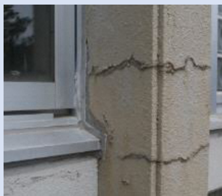
外壁(柱)亀裂
