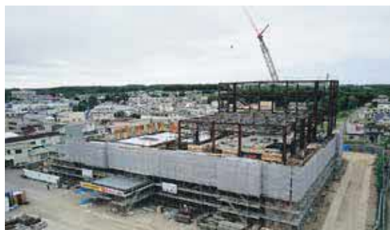
工事中の生涯学習センター
