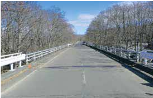
橋梁の補修工事
