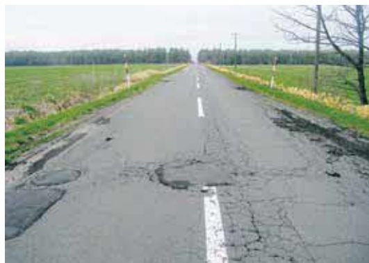
舗装修繕工事
