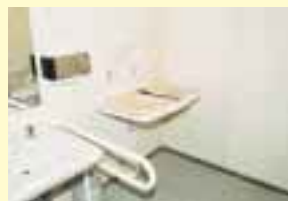
身障者用トイレ内部
