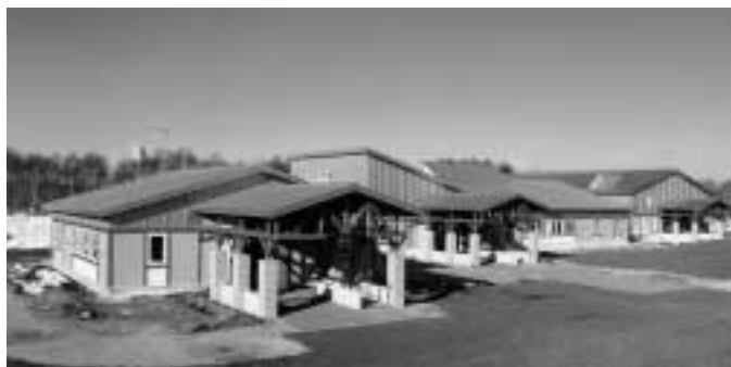
地域センター併設の尾岱沼支所
