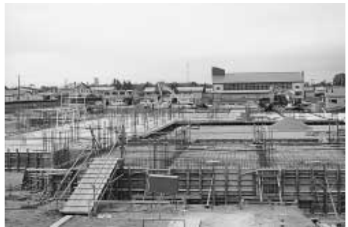
工事着工に至った別海高校
