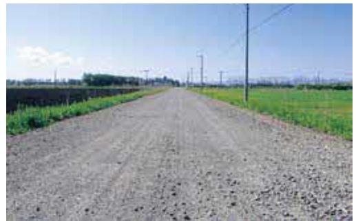
未舗装道路の改良舗装工事
