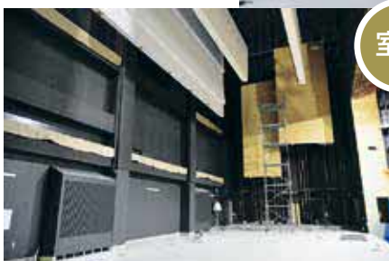
音響反射板が吊られた舞台
