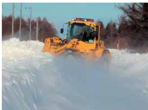
2月20日から連続する降雪により難航した除雪作業
