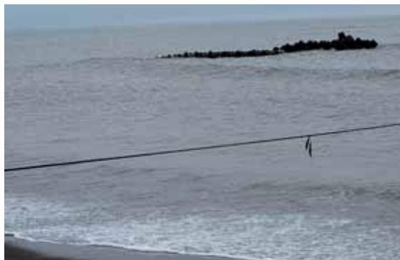
昭和後半に設置された突堤消波ブロック ※写真左（岸側）は水没している状況
