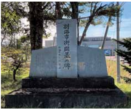
解体予定地にある「別海市街開基の碑」
