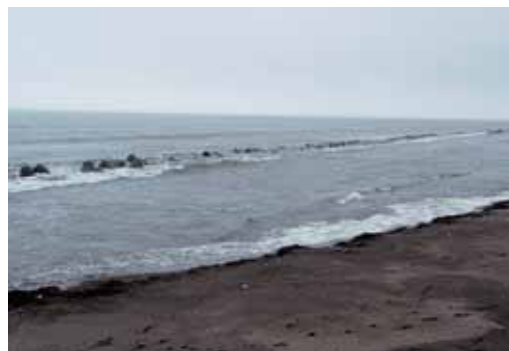
西別川南側に設置された並行消波ブロック ※満潮時は機能が大きく低下している状況
