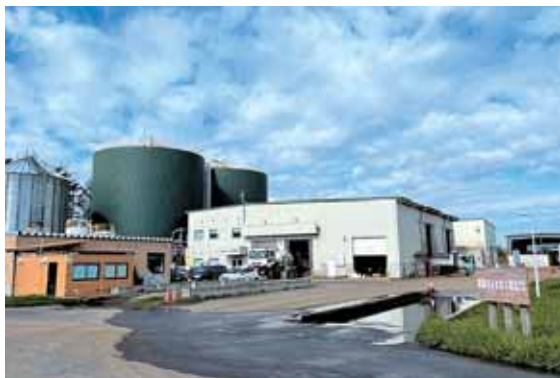
別海バイオガス発電施設
