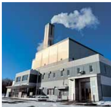
今後大きな改修が必要となるゴミ焼却施設
