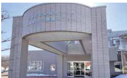
別海町民保健センターに設置されたこども家庭センター
