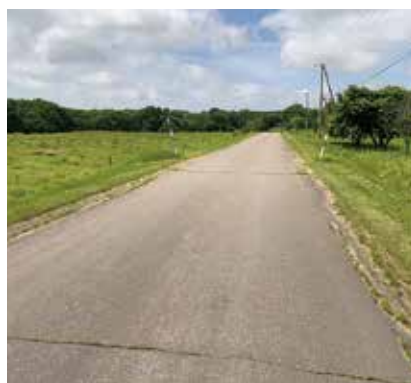
路肩の草刈も進み整備された町道
