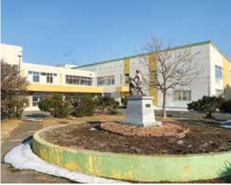
現在の中央小学校の外観
